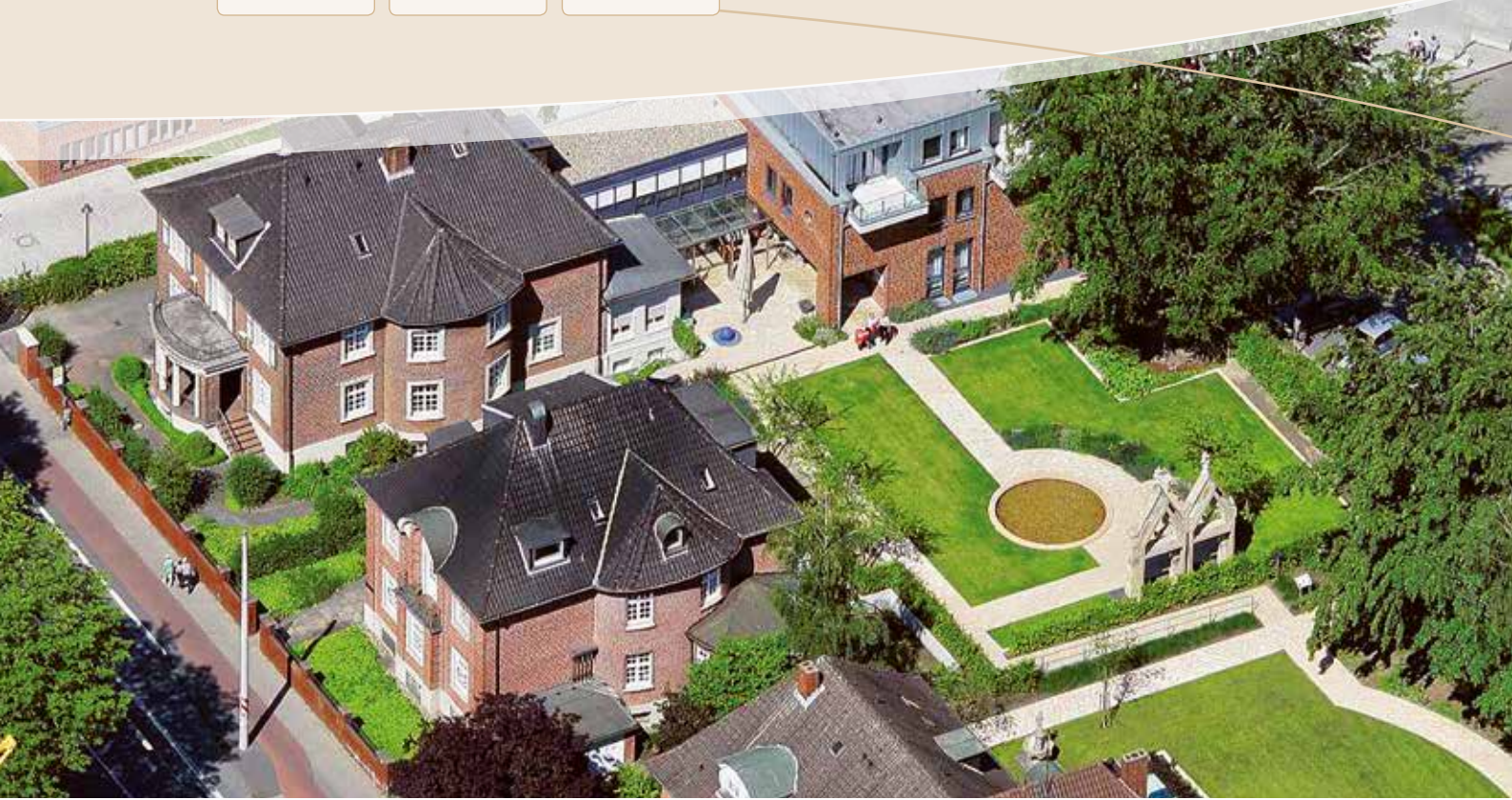
Luftbildaufnahme des Johannes-Hospizes (oben links) mit dem 2012 errichteten Anbau (oben rechts) und der großzügigen Gartenanlage
